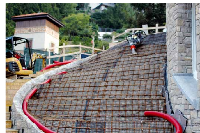
Terra rinforzata in contesto di edilizia privata
