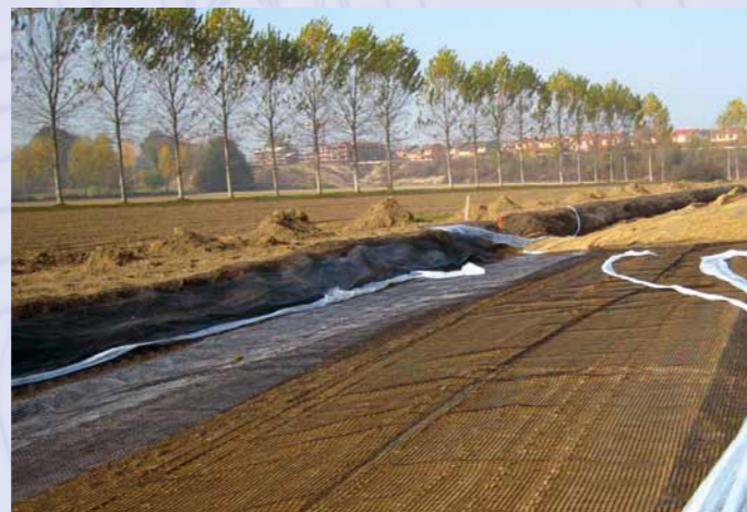
Applicazione delle geogriglie come rinforzo di fondo stradale
