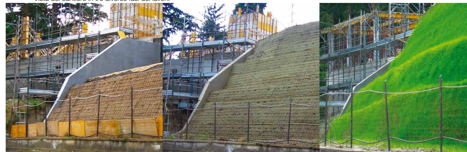
Vista del cantiere in tre diverse fasi dei lavori.
