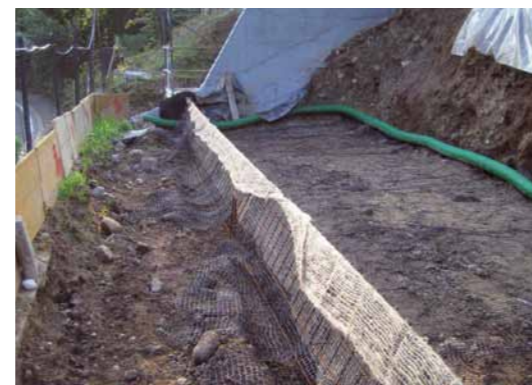
Particolare del drenaggio a tergo dell'opera all'inizio dell'installazione del sistema terra rinforzata. Il collettore drenante viene posto alla base del locale interrato.
