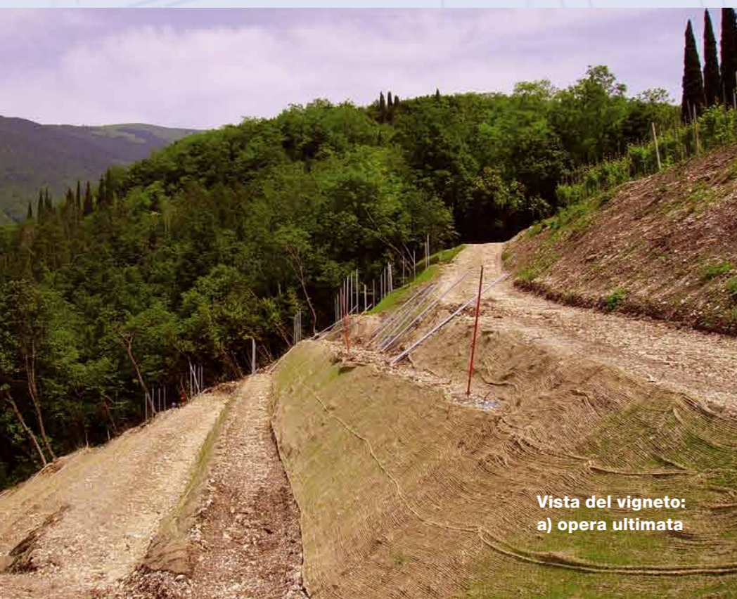
Applicazione delle geogriglie come rinforzo di fondo stradale
