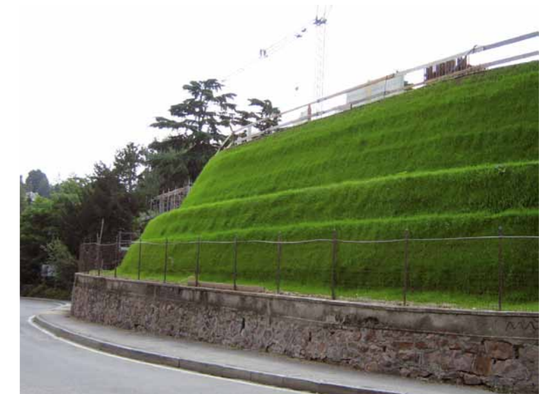
Dopo alcune settimane dall'idrosemina, il fronte è completamente rinverdito.
