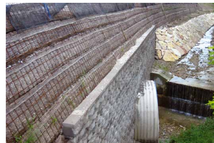
Opera di sostegno in ambito stradale
