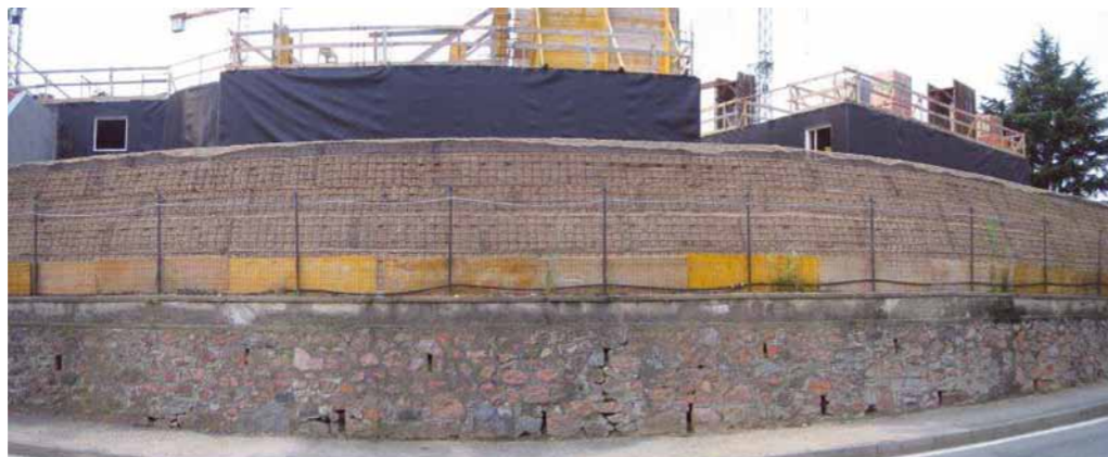
Particolare del drenaggio a tergo dell'opera all'inizio dell'installazione del sistema terra rinforzata. Il collettore drenante viene posto alla base del locale interrato.
