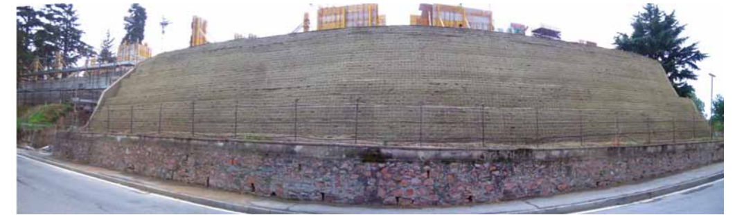
L'opera di sostegno in terra rinforzata ha raggiunto la sommità dell'edificio, rivestendo integralmente il locale interrato. E' già stata eseguita l'idrosemina a spessore per garantire una buona copertura del manto erboso.
