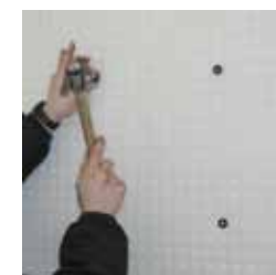
5 Fissare T-K Plaster al muro utilizzando T-Plug e T-Nail
