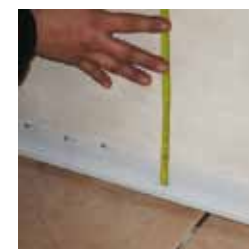
4 Misurare l'altezza da punto a punto del profilo; tagliare i rotoli di T-Kone Plaster a seconda delle superfici misurate
