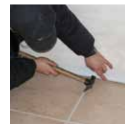
3 Fissare T-Kone Plaster Profile "in bolla" alla base e alla sommità della parete usando i chiodi in dotazione
