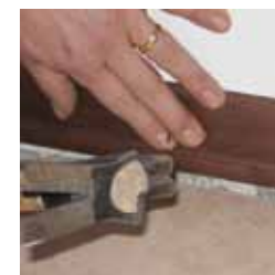
8 Posizionare sia sotto che sopra i battiscopa
