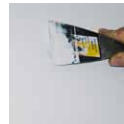
2 Regularizzare la superficie con dello stucco
