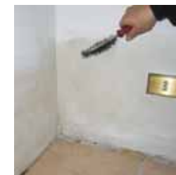
1 Pulire la superficie con una spazzola metallica
